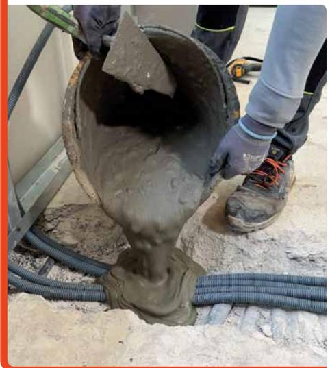
Per rendere più agevole l'infilaggio dei conduttori è disponibile la versione con tiracavo in acciaio preinserito. I tubi sono **autorinvenenti**, **autoestinguenti** e **lubrificati**. L'autoestinguenza aumenta la sicurezza: i tubi spengono autonomamente una fiamma in pochi secondi, arrestando o limitando la combustione una volta rimossa la fonte di calore. Così si riduce il rischio di propagazione dell'incendio e si previene la fusione del materiale.
