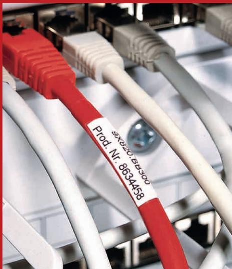
Alla stregua di qualsiasi altra etichetta, quelle autolaminanti vanno stampate (con stampanti a trasferimento termico o laser) oppure scritte a mano, per poi applicarle sul cavo o tubo da indentificare partendo dalla parte scritta e arrotolando la sovralamina trasparente attorno al cavo, fino a coprire almeno una volta la parte stampata.
